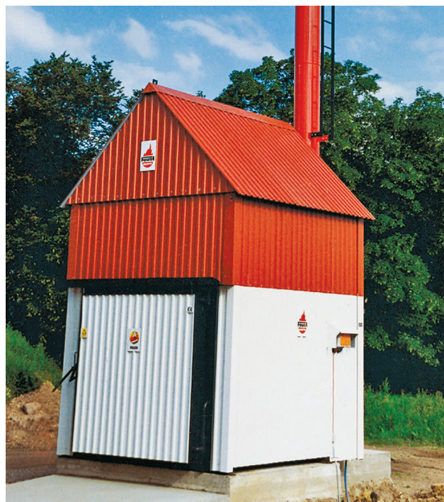
Centralele porționate sunt adesea instalate într-o clădire separată pentru a reduce riscurile de incendiu. Fotografie Torben Skøtt, BioPress.
