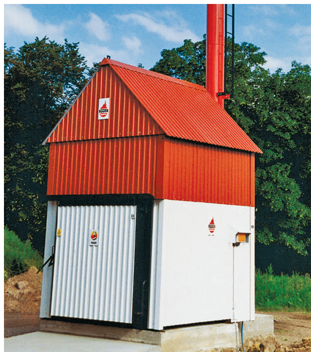
Las plantas de porciones se instalan a menudo en un edificio separado para reducir los riesgos de incendio. FOTO Torben Skøtt, BioPress.
