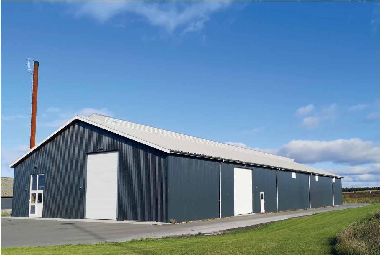
Depuis la décentralisation de la production d'énergie danoise dans les années 1980, de nombreuses petites centrales produisent aujourd'hui de l'électricité et du chauffage urbain. PHOTO Kirsten Krogh.
