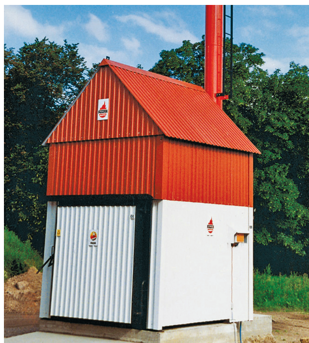
Les chaufferies sont souvent installées dans un bâtiment séparé afin de réduire les risques d'incendie. PHOTO Torben Skøtt, BioPress.
