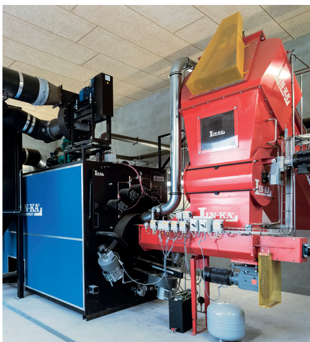
Chaudière automatique de 800 kW de Linka Energy. PHOTO Linka Energy.
