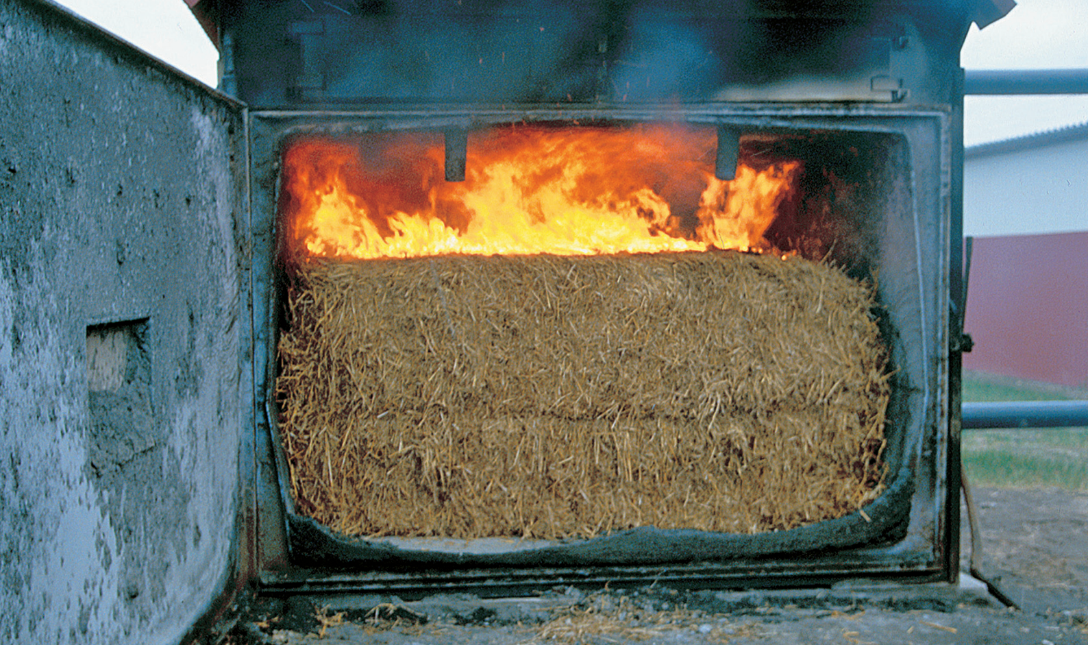
Foyer à alimentation manuelle pouvant accueillir des grandes balles carrées. PHOTO Torben Skøtt, BioPress.
