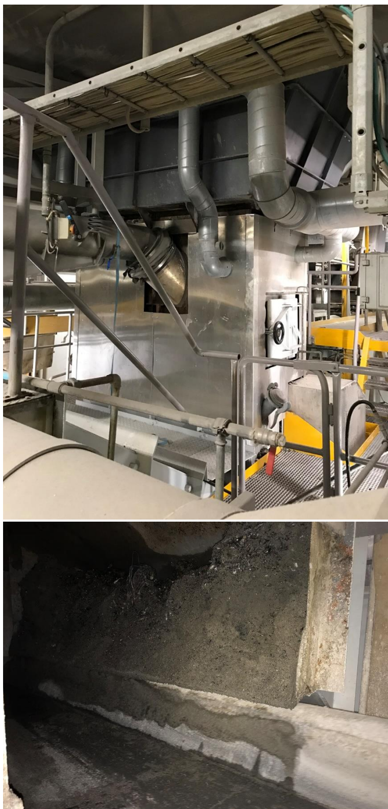
Askeudtagning i bunden af kedlen (øverst) og askeudkast på transportbånd efter slukning i vandkar (nederst).
